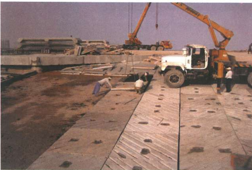
▲ اجرای عرشه و کارگذاری دال
