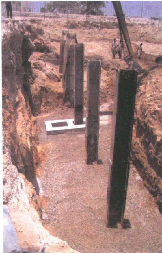
▲ تسطیح بستر دریا و کارگذاری دال‌های کف
