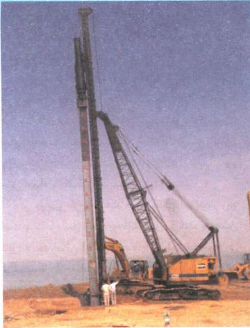
▲ عملیات شمع کوبی
