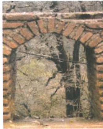
▲ شکل ۱۱: مدل‌سازی قوس استفاده شده در دیوار شمال غربی قلعه
