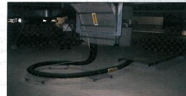
شکل ۱۰- جزئیات تاسیسات مکانیکی انعطاف‌پذیر در سازه‌های مججهزه جداگر لرزه‌ای
